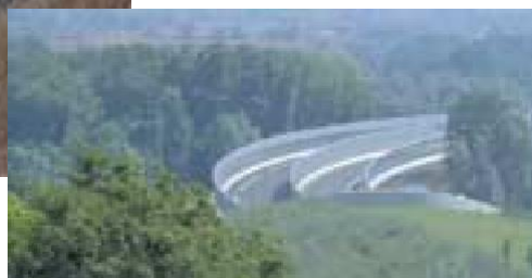
Tranchée couverte sur l'autoroute A14
