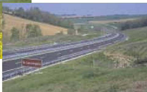
Insertion de l'autoroute A66
