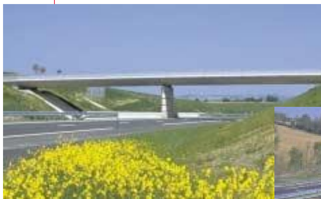
Insertion paysagère de l'autoroute A66
